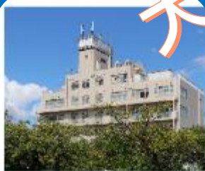
ナーシングホーム智島 大阪府門真市北島町12-3
