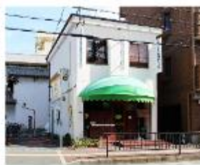
くすのき介護センター 大阪府門真市中町11-95
