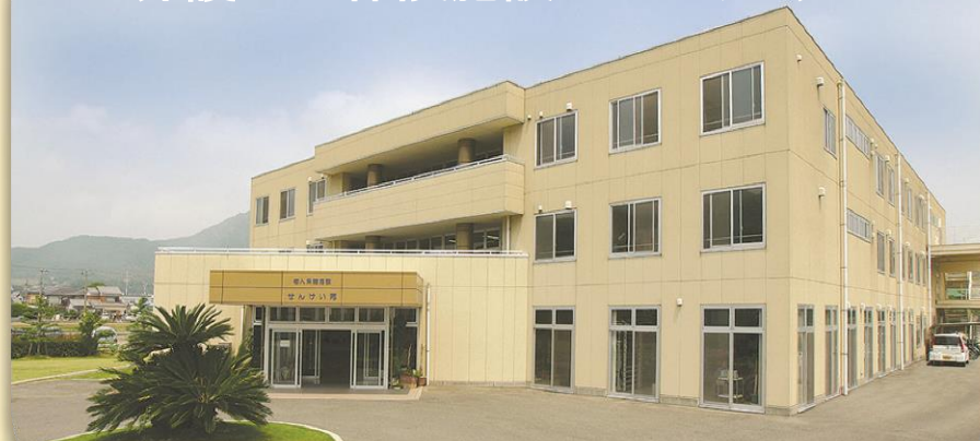
洲本伊月病院 本館
